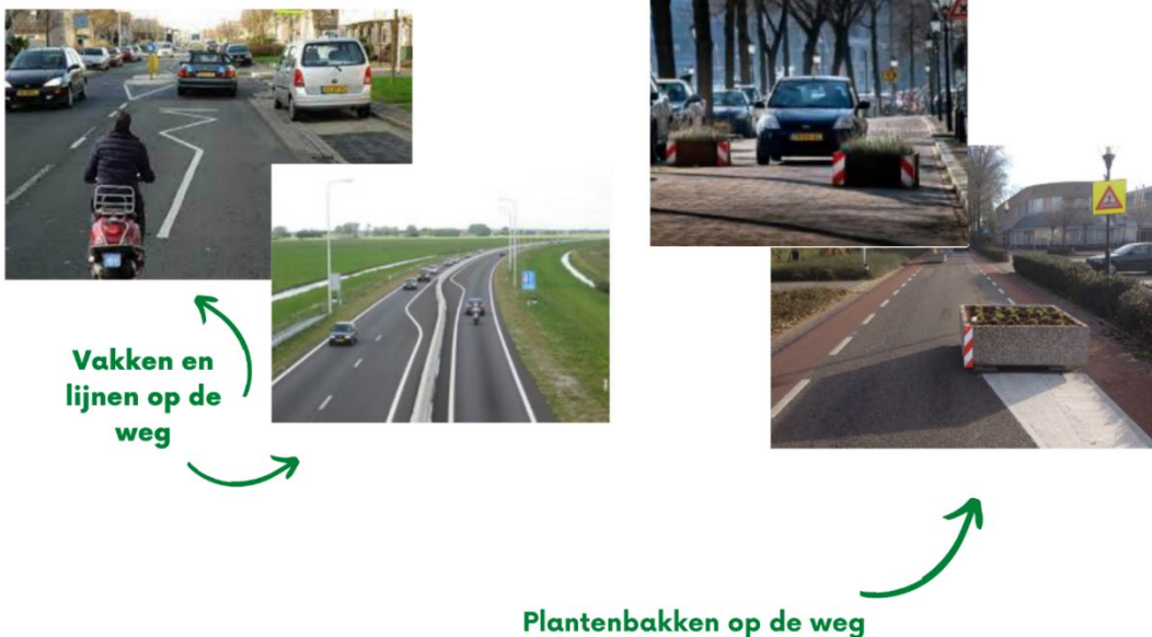
Figuur 24: Veranderingen aanbrengen op het wegdek om de snelheidsbeleving te beïnvloeden
